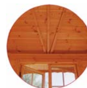
Vue intérieure du toit
