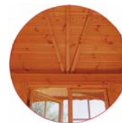
Vue intérieure du toit
