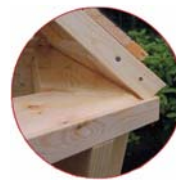
Corniche de toit
