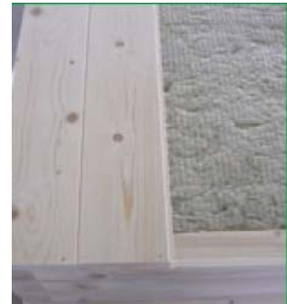
Plafond du sauna isolé
