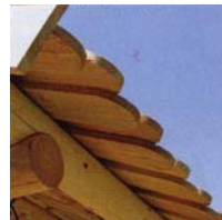
Encorbellement de toit
